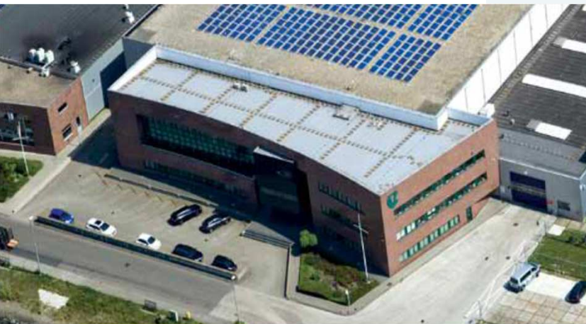
Zonnepanelen op vrieshuis in IJmuiden
